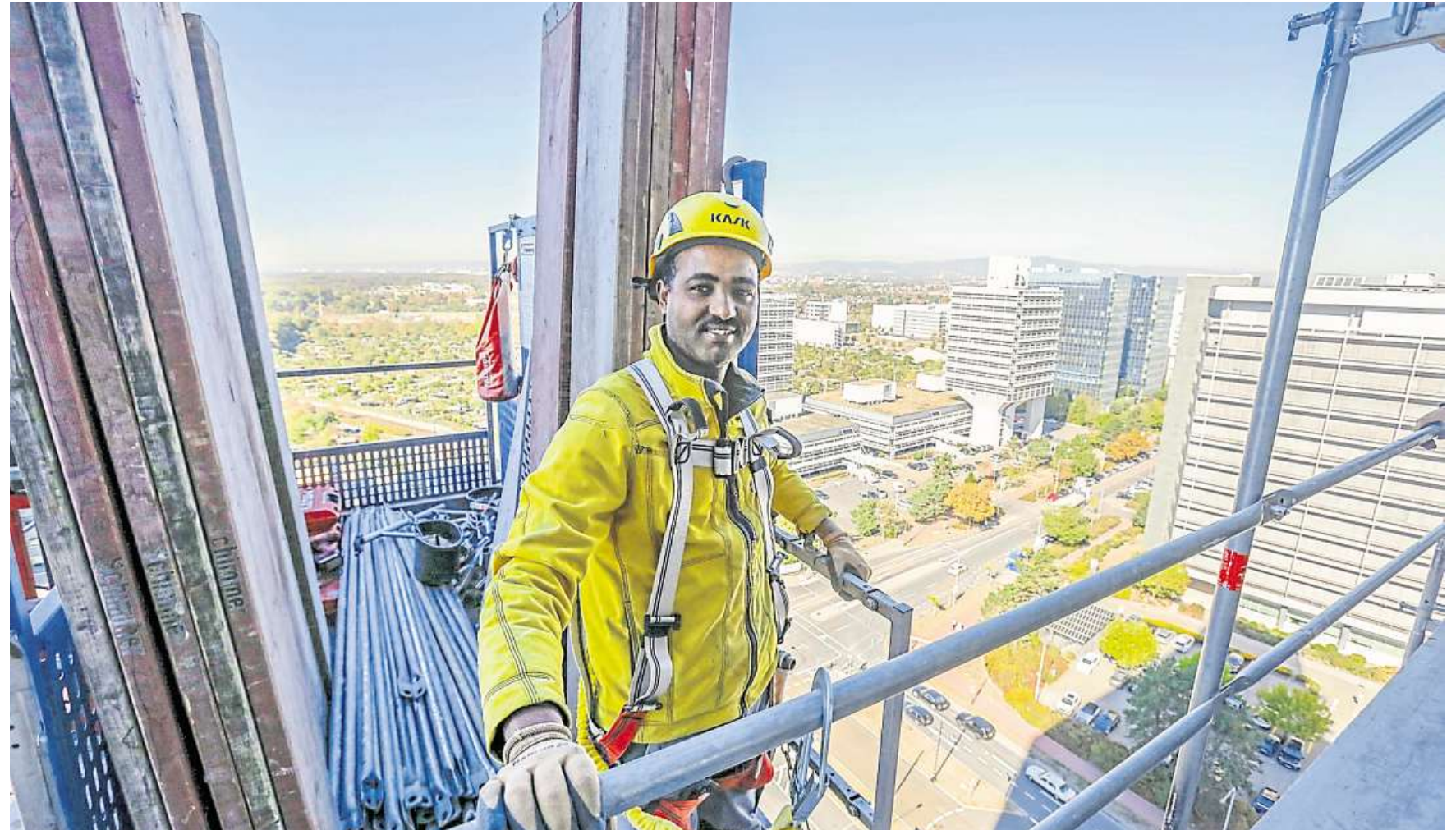
Helm ist Pflicht – und schwindelfrei sollte man als Gerüstbauer auch sein. Das Bild zeigt Gerüstbauhelfer Mulue Gebrekidan.
