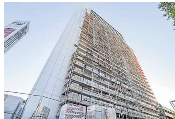
Dieses Hochhaus in Frankfurt bringt es auf 8000 Quadratmeter eingerüstete Fläche.
